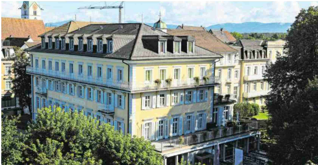
Der traditionsreiche «Schützen» in Rheinfelden wird derzeit erneuert.
